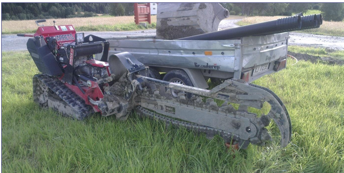
På noen gode strekninger ble det brukt en bandgraver. Foto: Egil Petter Stræte.
