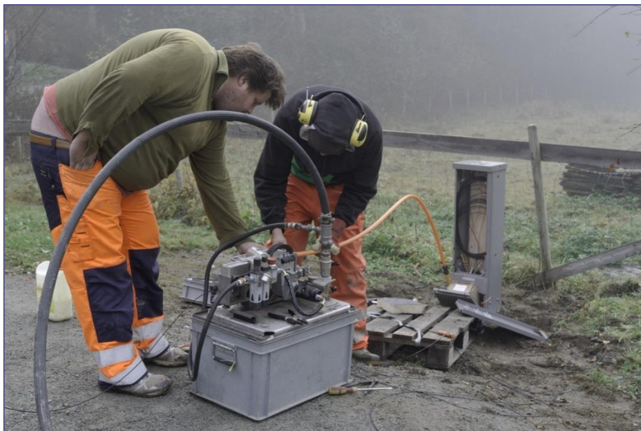
Blåsing av fiber pågår ved hjelp av kompressor. Foto: Børge Wahl.
