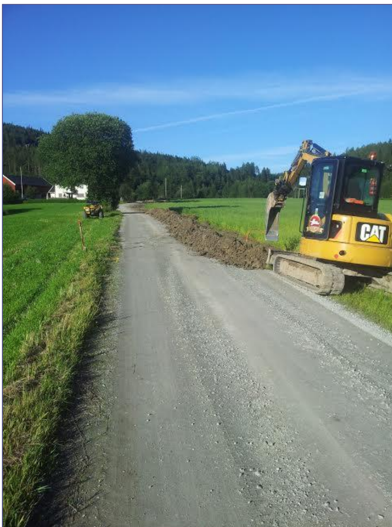
Dugnadsgraving ved Litjmarka. Foto: Svein Erik Gjølmesli.
