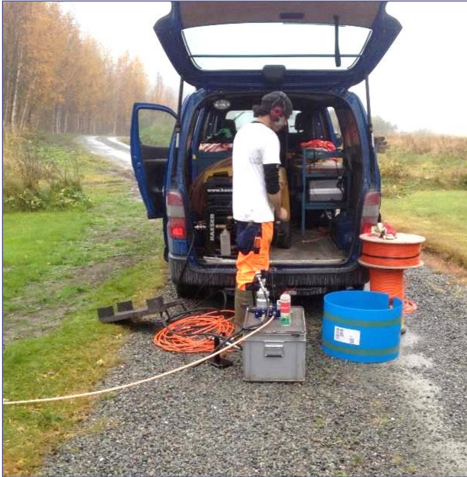
Anders Holmdin gjør klar utstyr til blåsing av fiber inn i trekkørerne. Foto: Vegard Hammermo.
