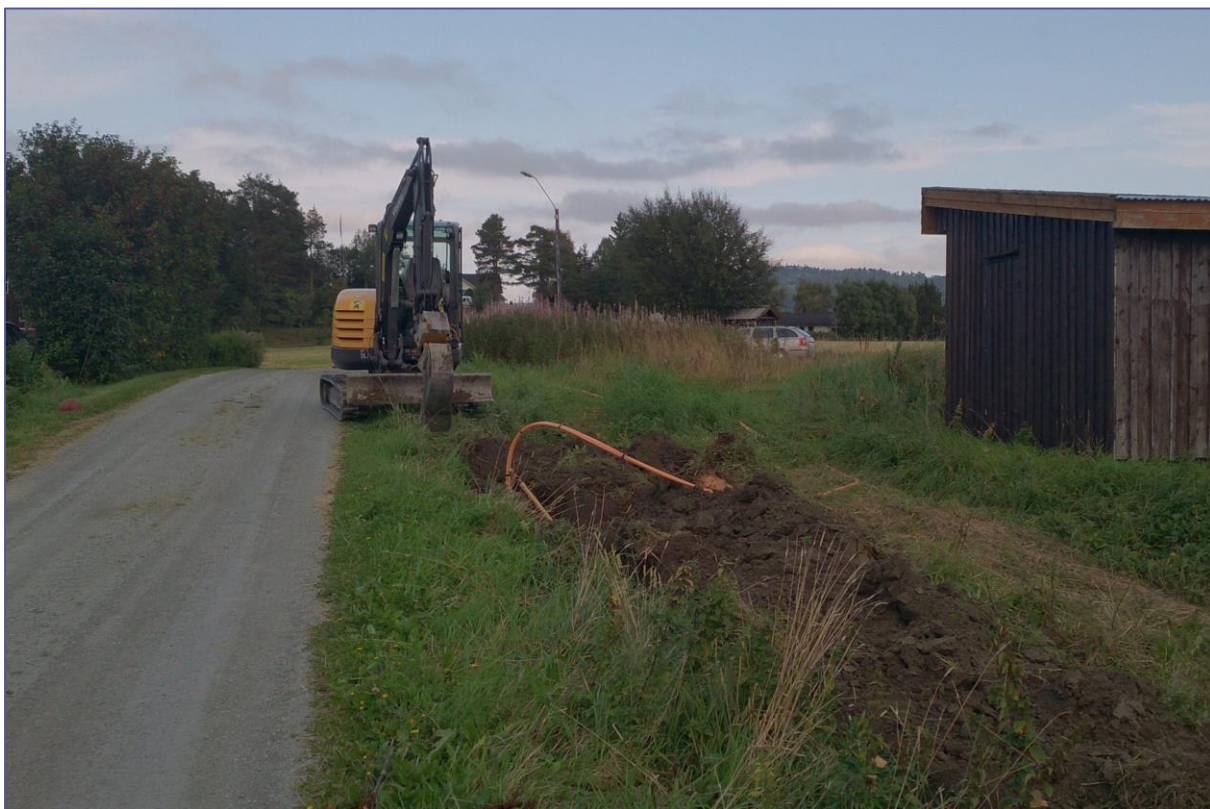
Dugnadsgraving ved Eidumslia. Foto: Helge Eide.
