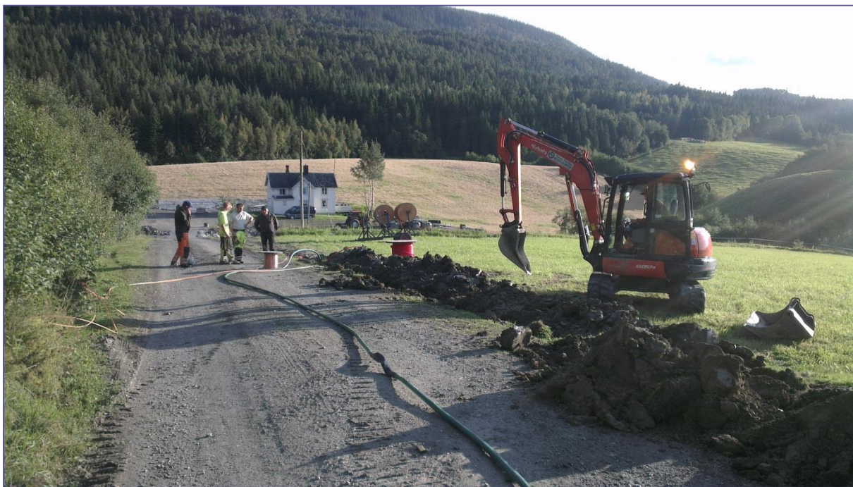
Grøfting ved Skjæret. Foto: Egil Petter Stræte
