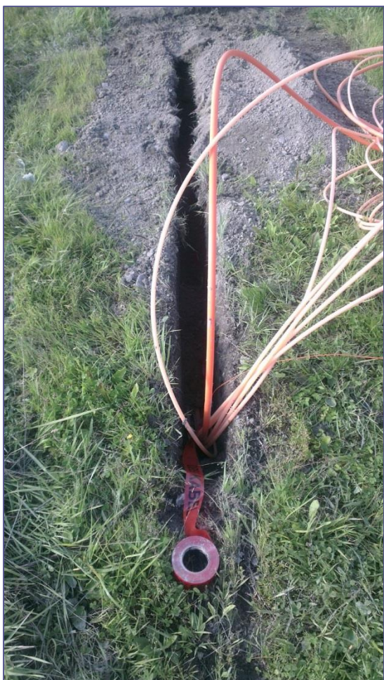
Smal grøft etter bandgraveren. Foto: Egil Petter Stræte.
