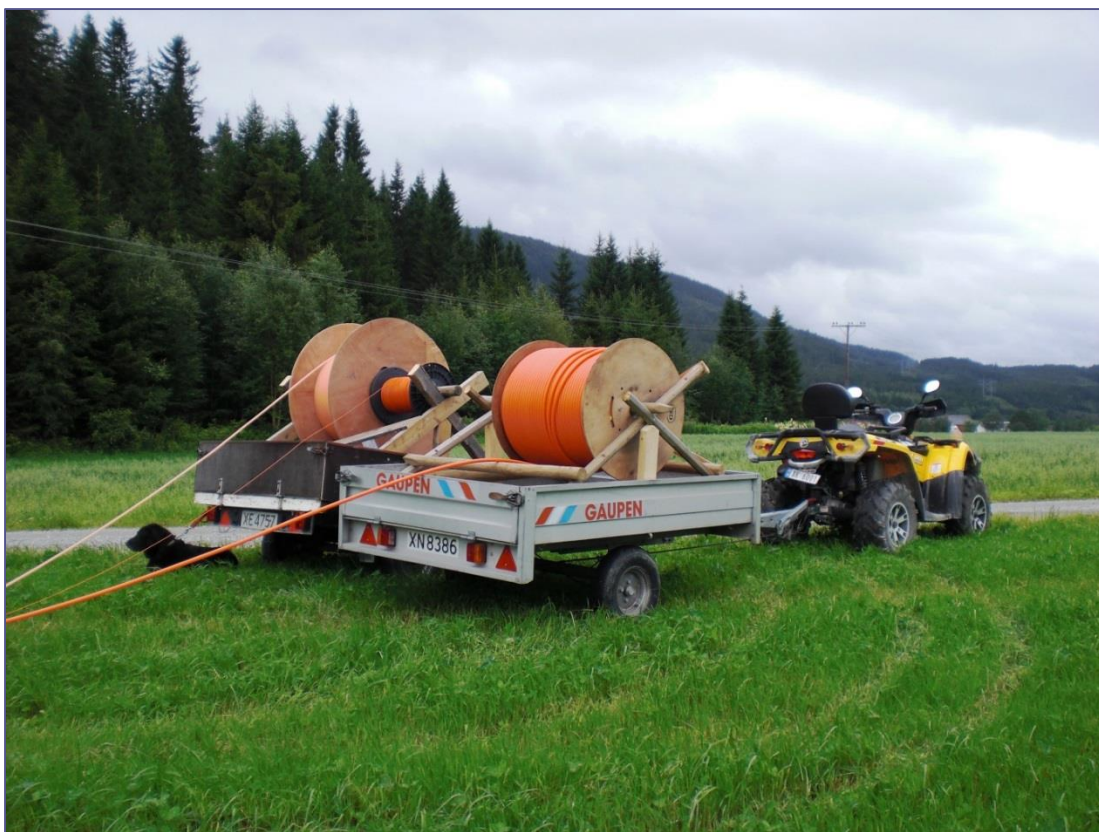
Sjølkomponert og effektiv rigging av trekkørtrømler. Foto: Egil Petter Stræte.
